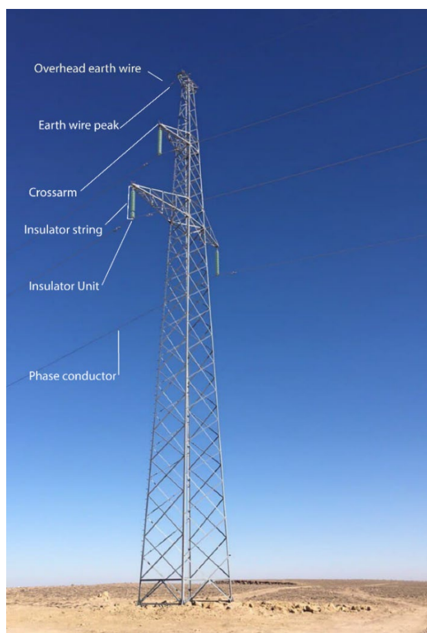
Рис. 13: Компоненты ВЛЭП (источник: Juru)
