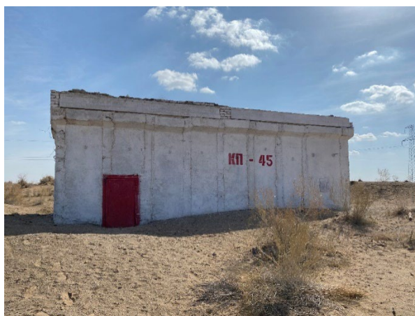
Рис. 4: Контрольно-пропускной пункт станции водоснабжения
