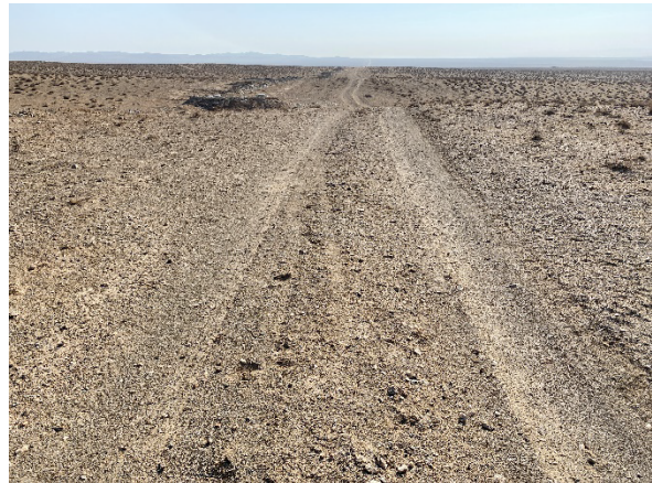
Рисунок 10: Состояние подъездных дорог в нескольких районах
