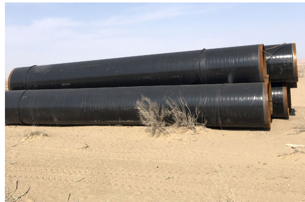
Рисунок 19: Водопроводные трубы, которые будут использоваться для строительства новой трубы
