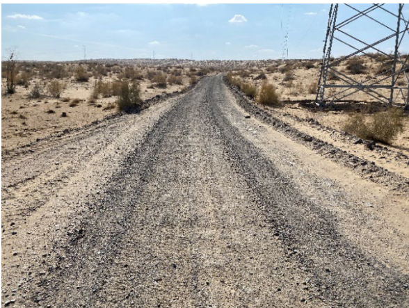
Рисунок 11: Подъездная дорога (от ~105 км до 205 км)
